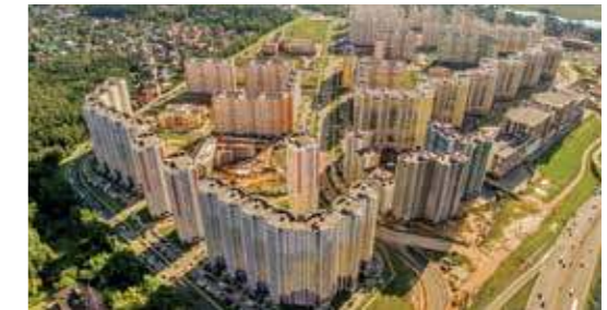
ЖК «Солнцево-парк» Московская обл., пос. Внуковское, д. Пыхтино
